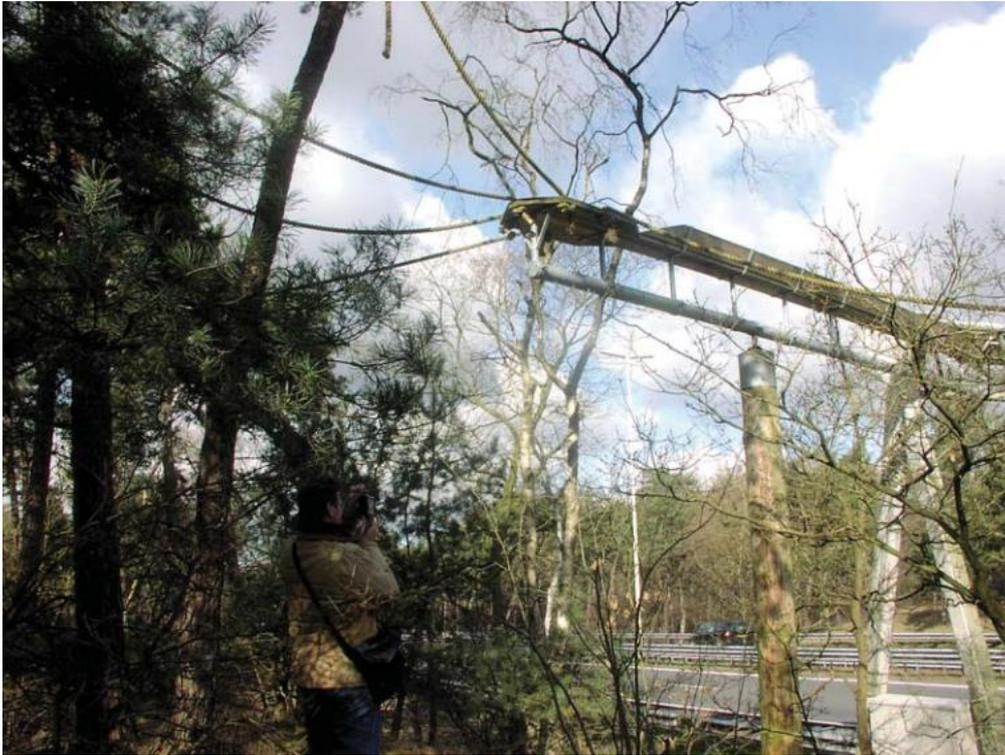
**FIGURA 27.** Exemplo de estrutura de sobre-passagem, que podem ser implantadas no local - travessia de dossel instalada em fixação de sinalização permanente e cordas que se estendem até o dossel da floresta.
