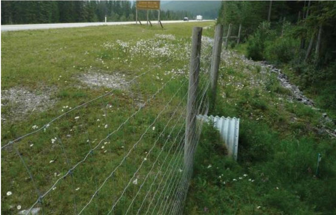
**FIGURA 26.** Exemplos de estruturas de subpassagem, que podem ser implantadas no local – túneis com cercas direcionadoras.
