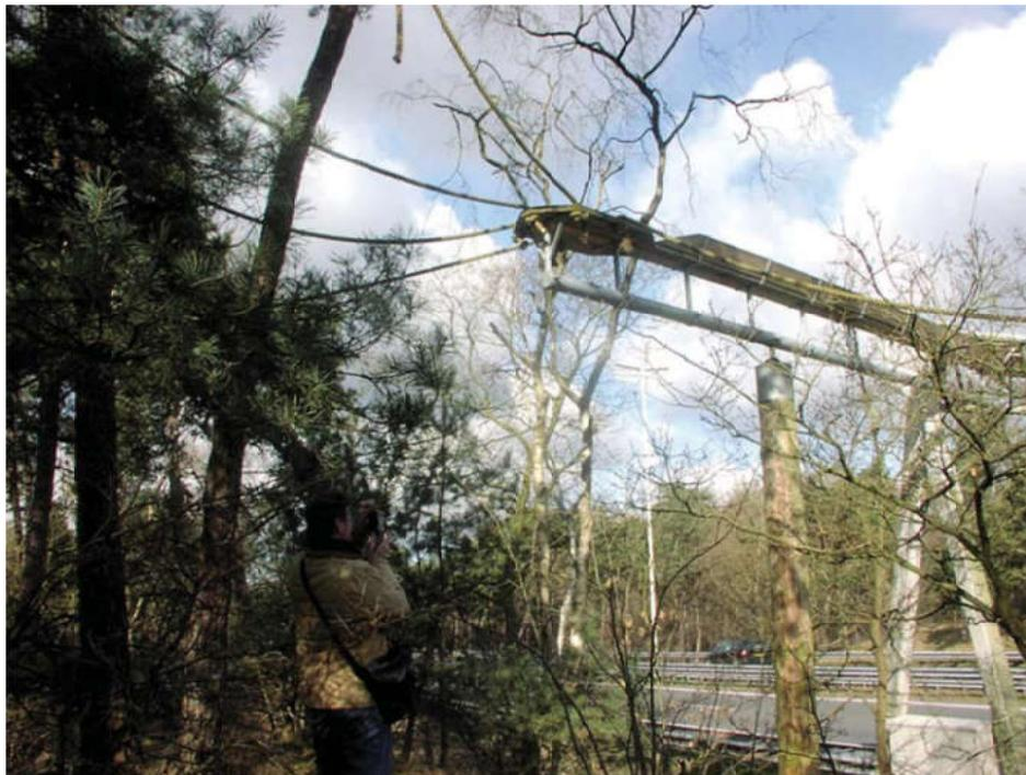
**FIGURA 26.** Exemplo de estrutura de sobre-passagem, que podem ser implantadas no local - travessia de dossel instalada em fixação de sinalização permanente e cordas que se estendem até o dossel da floresta.
