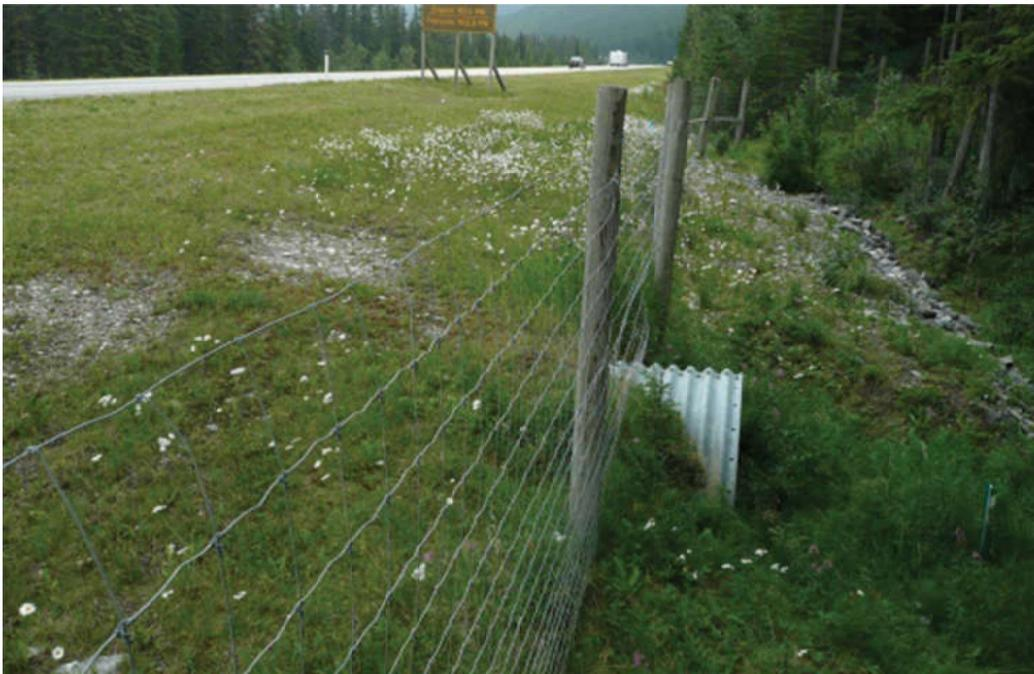
**FIGURA 25.** Exemplos de estruturas de subpassagem, que podem ser implantadas no local – túneis com cercas direcionadoras.
