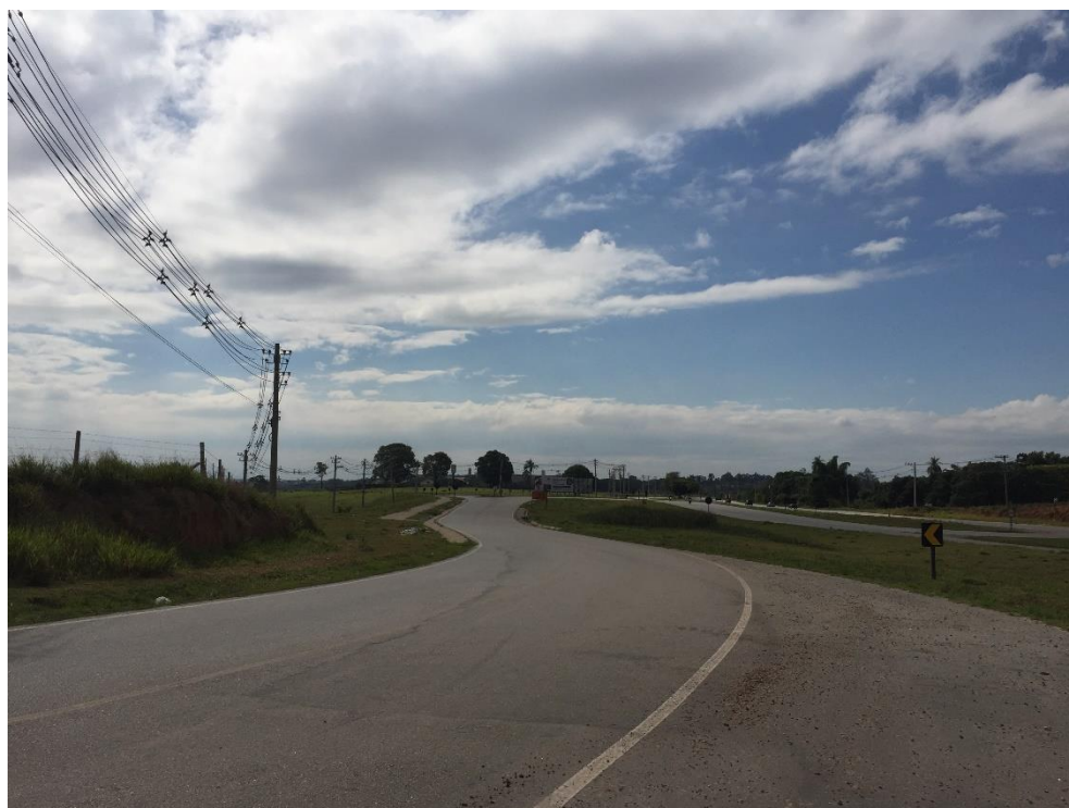
Vista da Estrada Municipal Augusto Zanoni no entroncamento com a Rod. SP-079, outro acesso ao Empreendimento.
