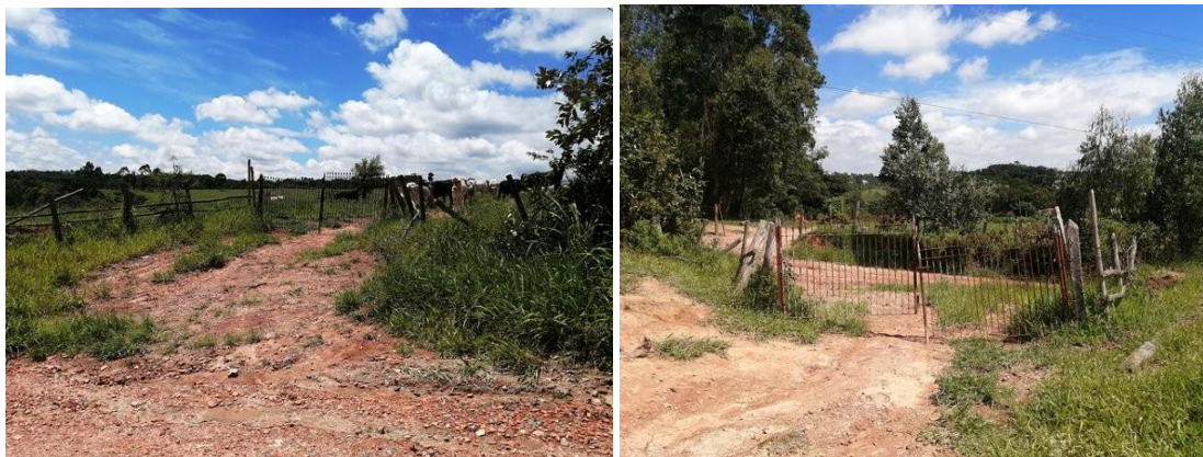
Figura – 6.37 e 6.38 – Vista da entrada de acesso ao empreendimento a partir da Estrada Municipal - Itu 493.
