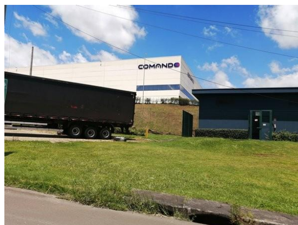
Figura 6.75 – Outra vista da empresa COMANDO (Condomínio Industrial Aurora Business Park 2).
