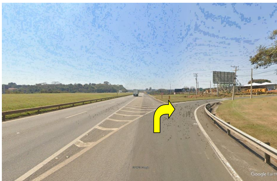
Figura – 6.77 - Vista do acesso da Rodovia Senador José Ermírio de Moraes – SP 075, para a Estrada Municipal ITU - 493 que dará acesso à gleba do empreendimento.
