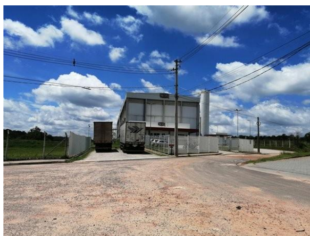
Figura 6.72 – Vista da empresa RICHS (Condomínio Industrial Aurora Business Park 2).
