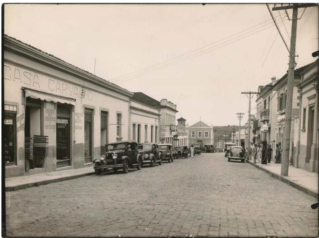
Figura 17 – Pavimentação em paralelepípedo do início do século XX
